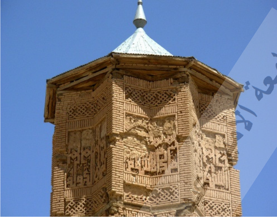
الصورة 43، بقايا الزخرفة الخطية في مئذنة مسجد غزنة
