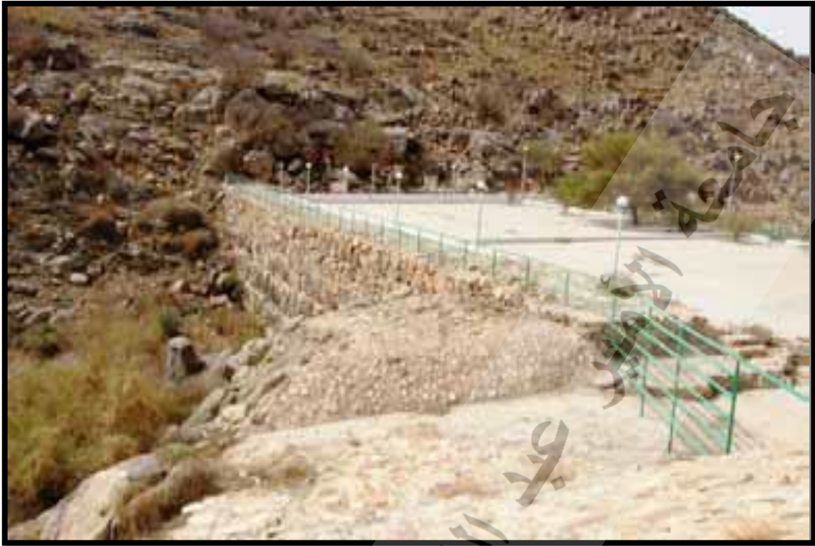
صورة سد سيسد: منظر عام للسد ويلاحظ الواجهة الخلفية المتدرجة والمفيض والسطح العلوي لجسم السد
